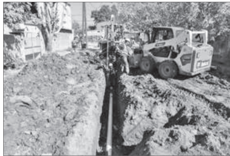
En 40 días de trabajo se construyeron conexiones domiciliarias para 30 familias.
