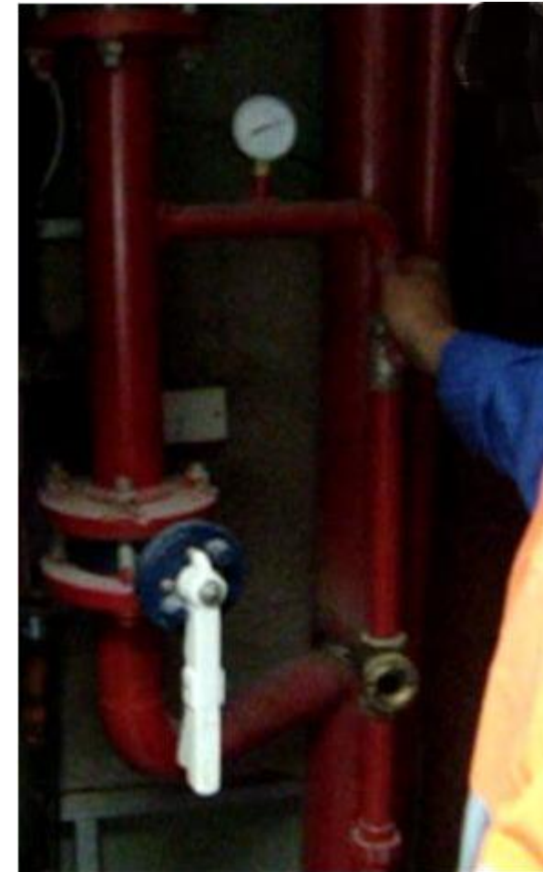
Sistema de Chequeo de Rociadores (próximamente)
