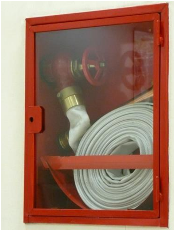
Gabinetes de Hidrantes Para uso de Bomberos
